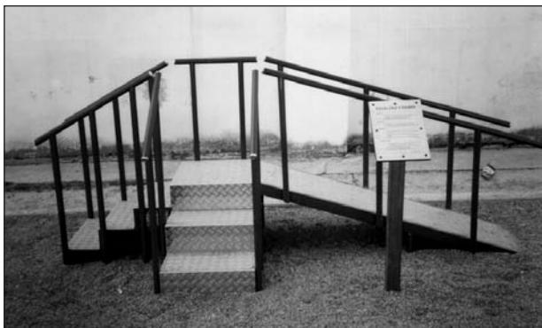
Fig. 6. Escaleras y rampa.
