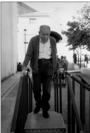
Fig. 8. Escaleras y rampa: suelo metálico antideslizante.
